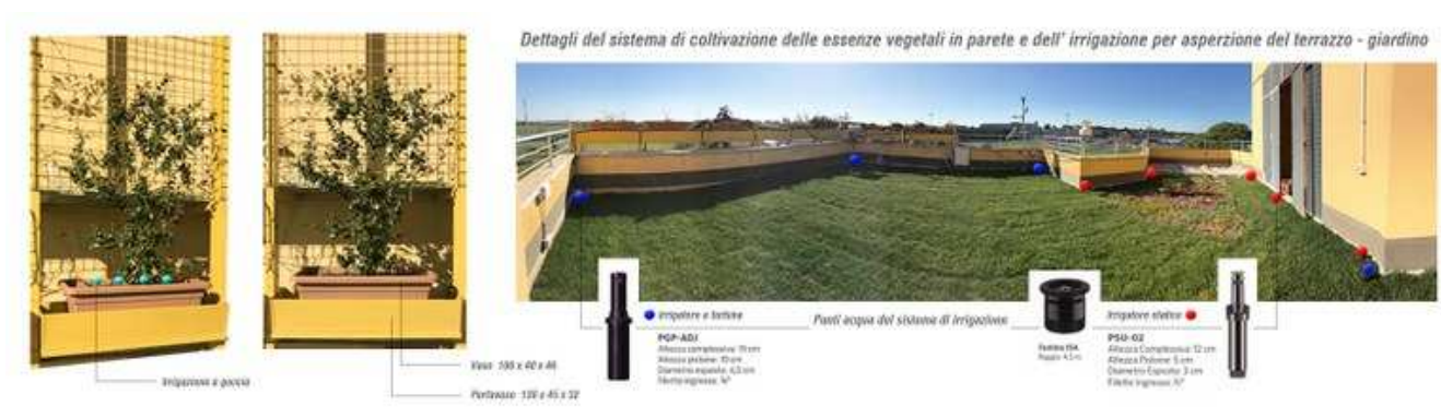
Figura 1 - Particolare del prototipo tetto-giardino sull'edificio dimostrativo del Centro Casaccia
