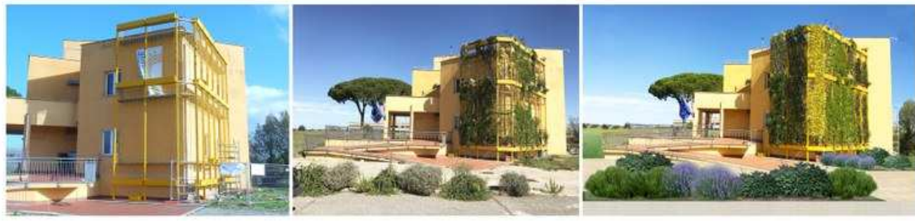
Figura 2 - Prototipo della parete-verde sull'edificio dimostrativo del Centro Casaccia
